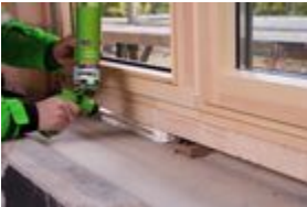
Verarbeitung des Fensteranschlusses mit FM230.
